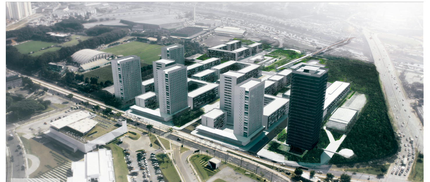
VISTA AÉREA DO CONJUNTO
