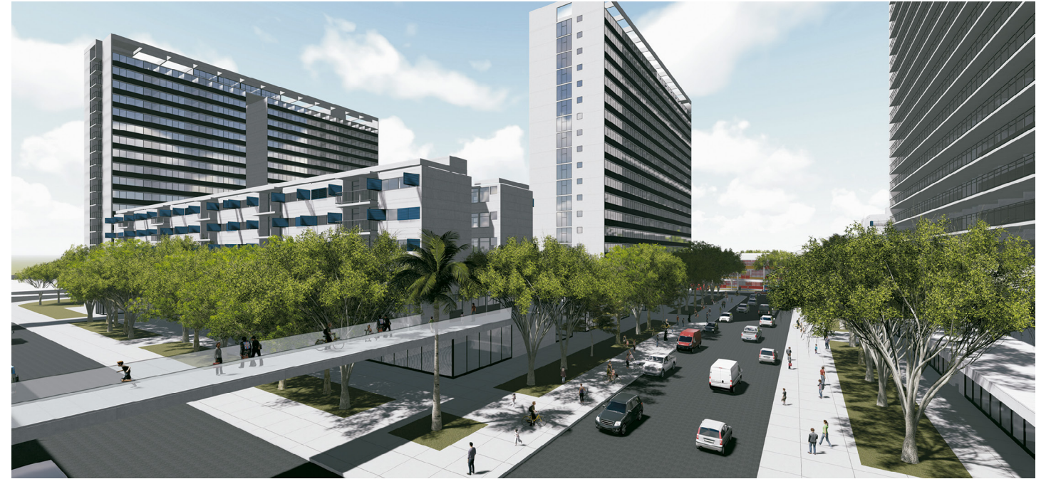
VISTA DA QUADRA HABITACIONAL 2
