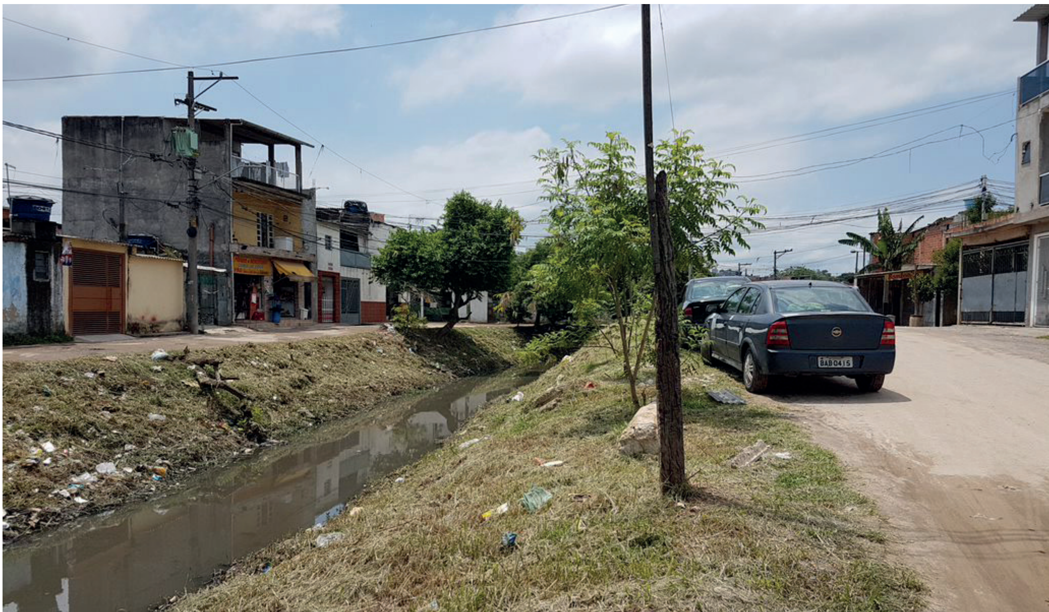
Área do Jardim Pantanal, junto à rua Cachoeira Itaguassava, que vai receber infraestrutura de água e esgoto. Foto: Letícia Lemos
